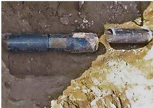
شکل ۲. آسیب ناشی از خارج شدن لوله از محل اتصال واشر آب‌بند بلند (long RR)
